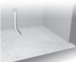
Vor dem Verlegen der Heizmatte auf dem Estrich, muss der Untergrund sauber, trocken, fest, staub- und schmutzfrei sein. Sollte der Unterbau uneben sein, so ist dieser vor der Verlegung der Heizelemente zu nivellieren, sodass Hohlräume unterhalb der Heizleitung vermieden werden. Bewegungsfugen in der Unterkonstruktion dürfen auf keinen Fall mit dem Flächenheizelemente überbrückt werden.
